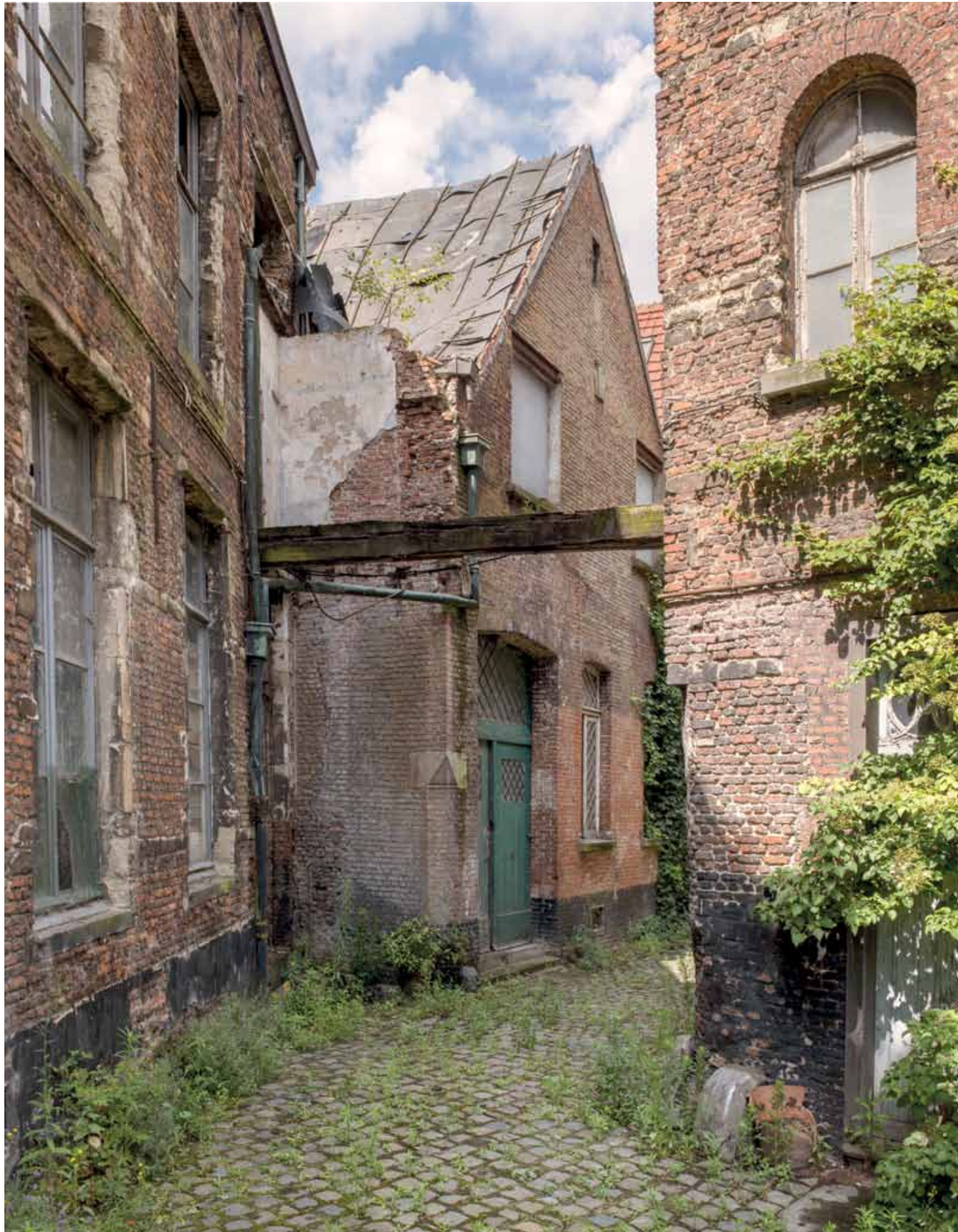
Afgebroken Potagiepoort. Foto: Karin Borghouts, 2015
