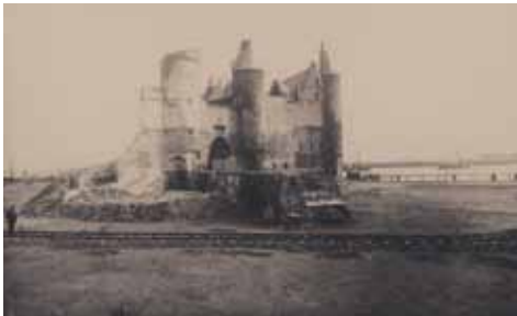
Het Steen tijdens de afbraakwerken
