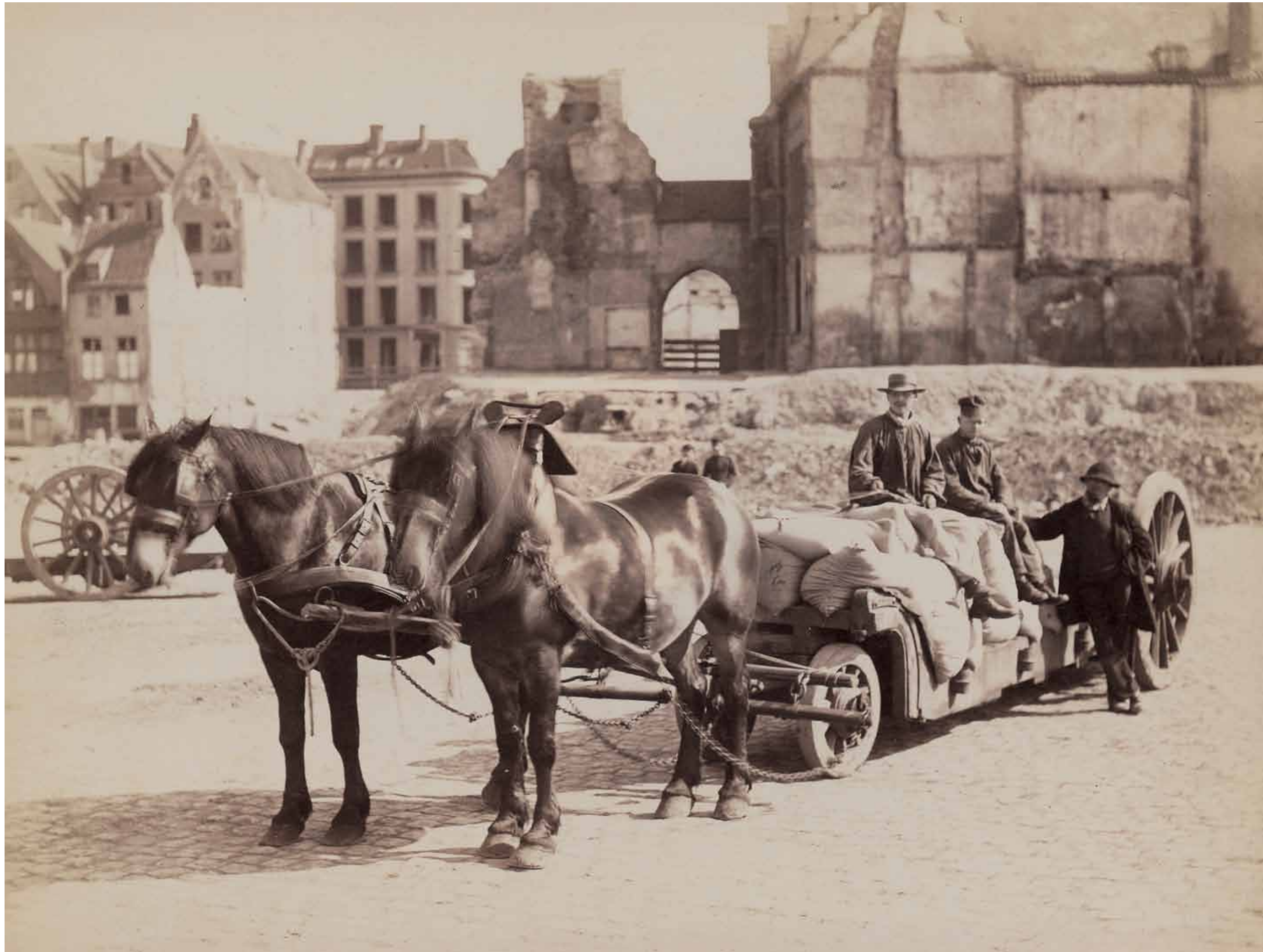
Afbraakwerken, aanvoer van materiaal, ca. 1883
