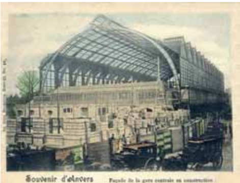
Centraal Station in opbouw
