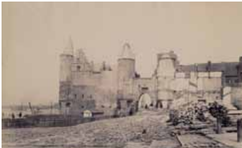
Het Steen tijdens de afbraakwerken
