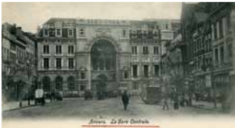
Centraal Station in opbouw, 1903
